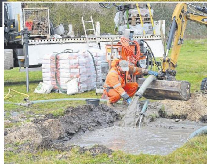
Valeri Buchner sibt das ausgespülte Bohrgut aus, um zu untersuchen, welche Schicht gerade erreicht ist.
