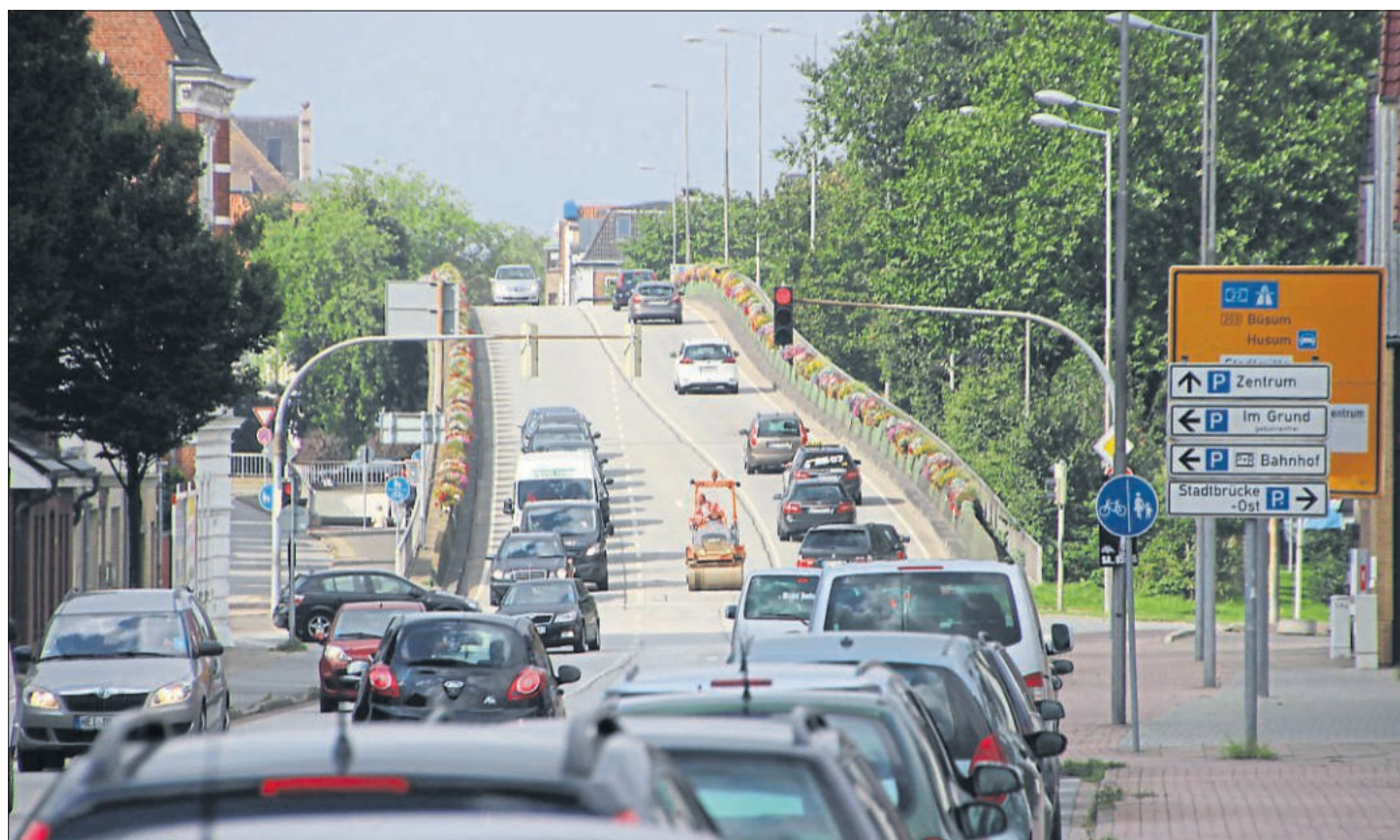
Rund 18 000 Fahrzeuge nutzen täglich die B 203 mit der Stadtrbrücke.
