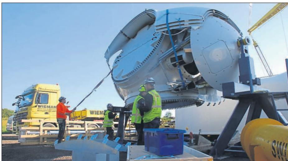
Die Nabe für die Rotorblätter ist aufgebockt. Arbeiter bereiten die Montage der Abdeckungen vor.
