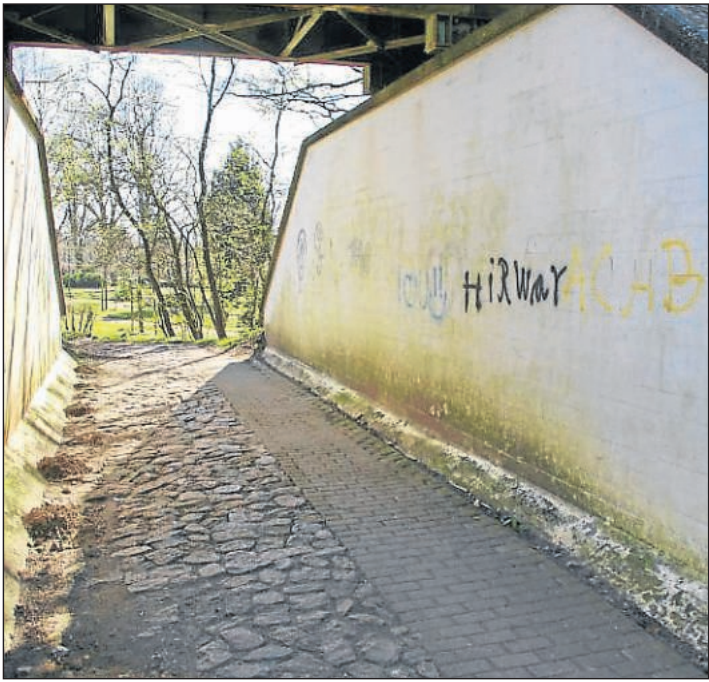
Die Schmierereien im Fußgängertunnel sollen bald der Vergangenheit angehören. Ein neues Graffito soll die tristen Betonwände verschönern. Foto: Schatt
